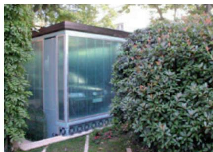
Cabina di protezione in policarbonato
